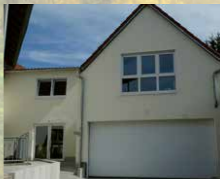
Blick auf die Zufahrt nach den Umbauarbeiten.
