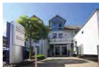
Die Kanzlei in Hammersbach Langenbergheimer Straße 11 - 13 63546 Hammersbach Telefon (0 61 85) 8 19 90
